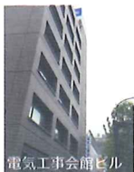
電気工事会館ビル
